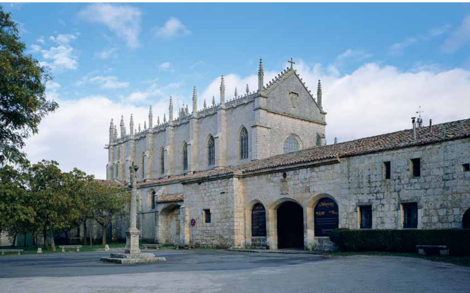
FIG. 2 Vista exterior de la Cartuja de Miraflores
