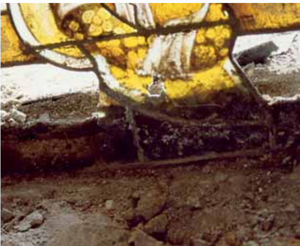
FIG. 33 Tapiado y recuperación de paneles en las vidrieras del sur
