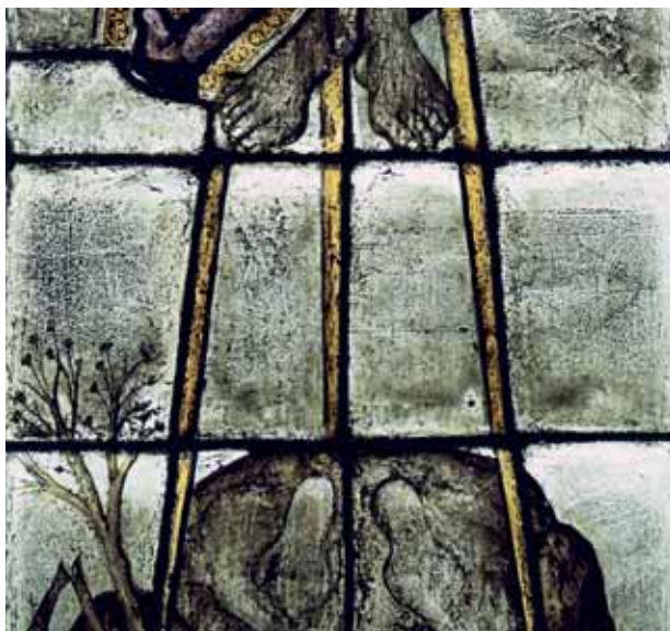
FIG. 26 Detalle de la vidriera de la Ascensión en la que se conserva la red de plomo original, del siglo XV
