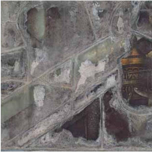
FIG. 29 Detalle de la vidriera del Descendimiento en el que se distinguen claramente los depósitos de suciedad sobre la cara interior
