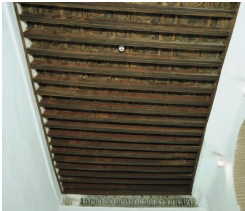
[FIG. 45] Artesonado de madera de la capilla del siglo XVI situada a los pies de la nave de la epístola
