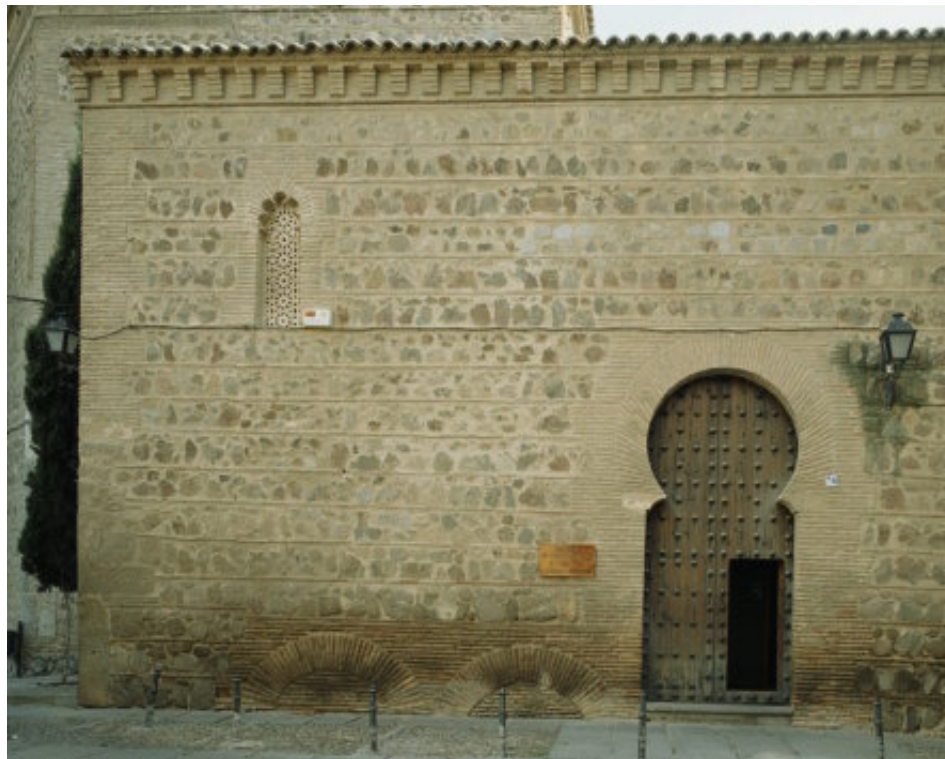
[FIG. 3] Muro exterior norte, acceso actual al templo
