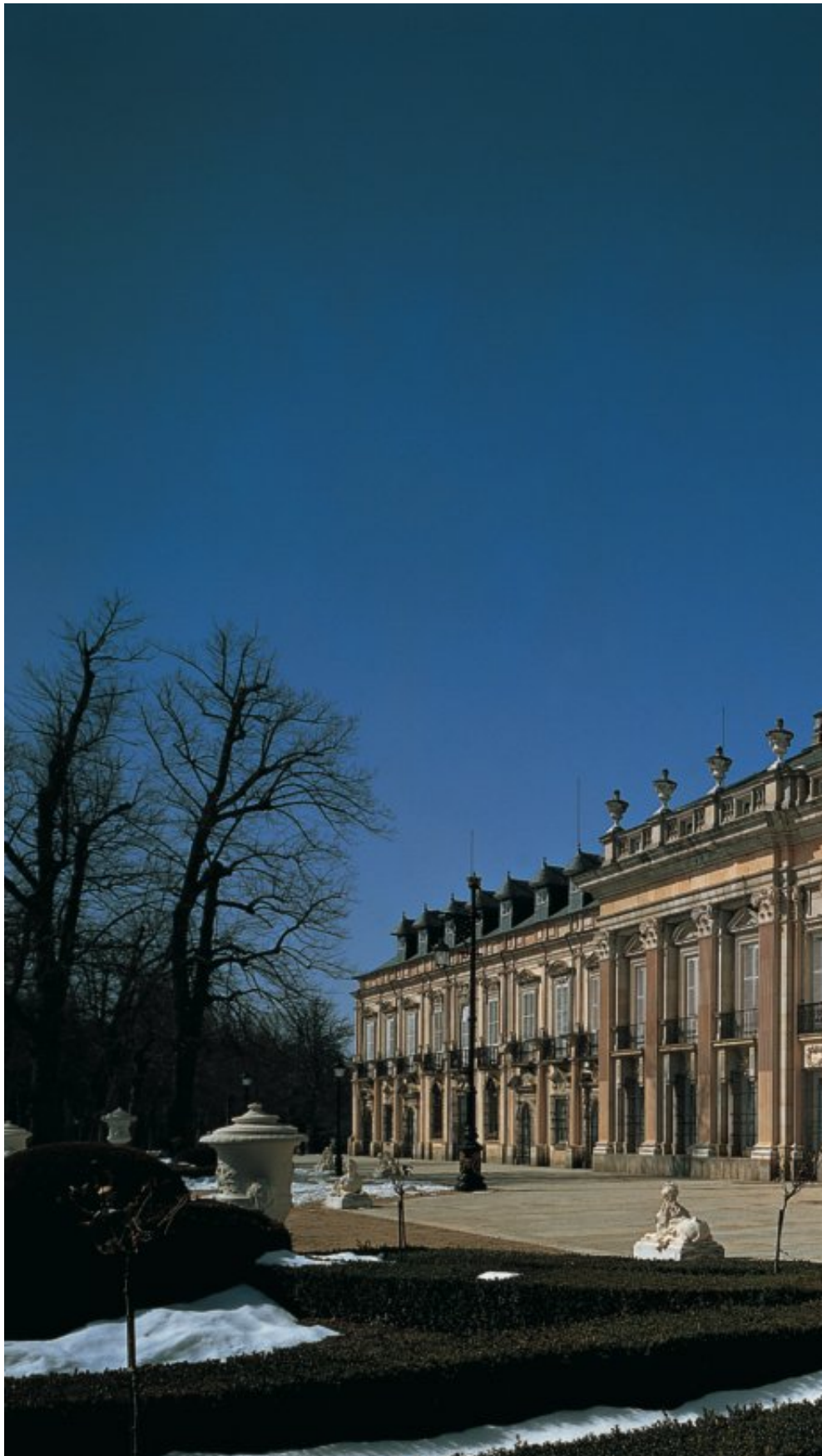
[FIG. 30] Vista general de la fachada oriental del Palacio Real de La Granja de San Ildefonso
