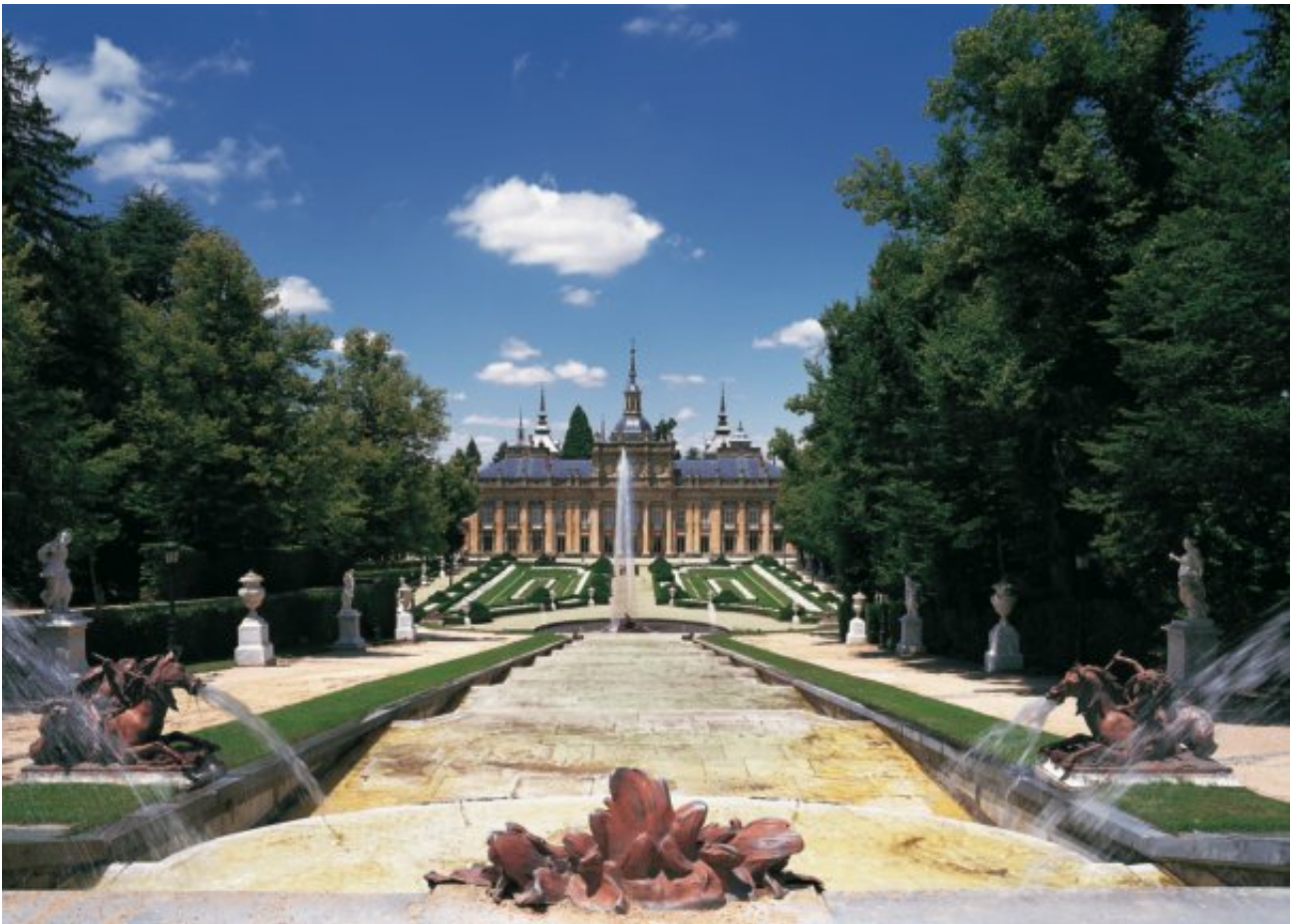
[FIG. 3] La fachada de Juvarra y Sacchetti desde lo alto de la Cascada
