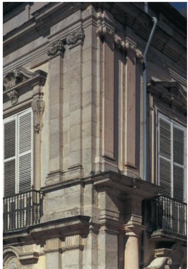
[FIG. 23] Andrea Procaccini, detalle de la esquina del ala sureste del patio de la Herradura con fachada a los jardines
